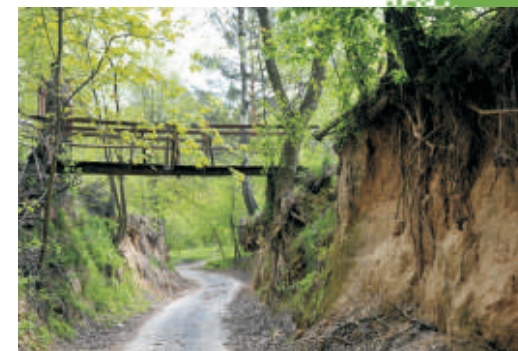
Mostek nad drogą w głębocznicy
