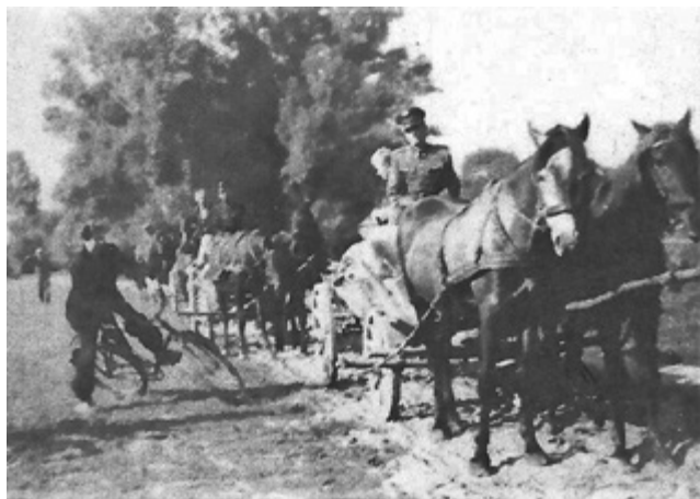
Zbiorowy wyjazd z Batorza do budowy wałów nad Wisłą
