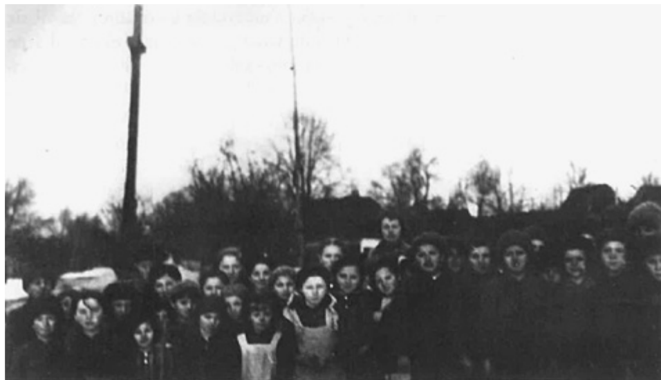
Młodzież szkolna zgromadzona na uroczystości poświęcenia fundamentów pod budowę szkoły, 22 VI 1931 r.
