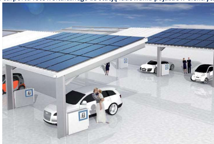
Schemat 8 Wizualizacja carportu fotowoltaicznego ze stacją ładowania pojazdów elektrycznych.
